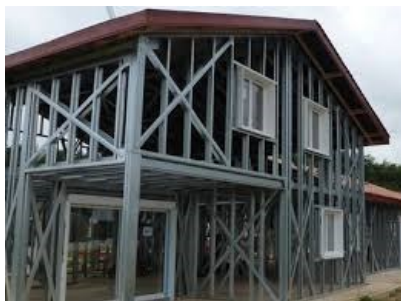
Maisons ossatures métalliques
