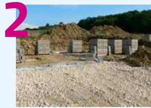
ÉTAPE 2 : Préparation du chantier
