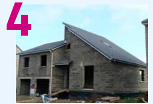
ÉTAPE 4 : Toit et façade
