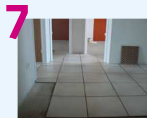
ÉTAPE 7 : Revêtements sols, menuiseries, plafond
