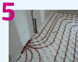
ÉTAPE 5 : Électricité et plomberie
