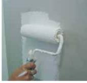
Appliquer une sous-couche adaptée au support à l'aide d'un rouleau, d'un pinceau.                                                                                                                                                                      |
