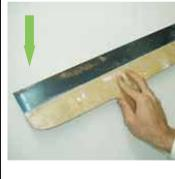
Lisser la surface de haut en bas avec un couteau à enduire ou d'une lisseuse. (épaisseur maxi de 1 à 2 mm). Laisser sécher puis poncer si nécessaire.                                                                                                  |
