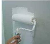
Appliquer une sous-couche adaptée au support à l'aide d'un rouleau, d'un pinceau.                                                                                                                                                                                |
