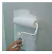
Appliquer une sous-couche adaptée au support à l'aide d'un rouleau, d'un pinceau.                                                                                                                                                                            |
