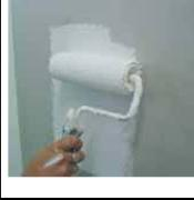
Vérifier que l'enduit est bien sec (doit être très blanc) puis appliquer une sous-couche adaptée au support à l'aide d'un rouleau, d'un pinceau.                                                                                                       |
